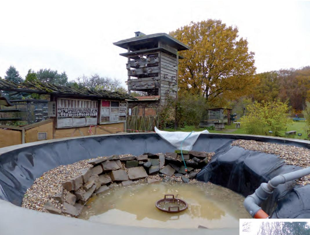
„ Für Kinder ist das Wasser fast auf Augenhöhe“. So berichtete am 23.11.2007 die WZ über den damals errichteten Hochteich. Für die Seitenwände des damaligen Baus in der statisch nicht optimalen Nierenform wurden gerissene Eichenpfähle gewählt. Nach Vorstellung aller Akteure sollte das Bauwerk mindestens 25 Jahre halten, was sich jedoch nicht bewahrheitete. Die Stabilität der Seitenwände ließ nach, eine aufwändige Reparatur lohnte nicht mehr.
