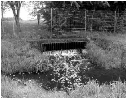
Auslauf des Regenrückhaltebeckens Klörather Steg
