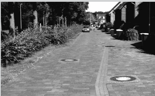
Hier liegt klar erkennbar ein Trennsystem vor.
