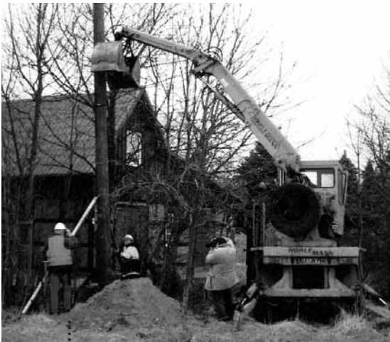
Der Strommast für den Nistkasten wird gesetzt. Foto: Hans Fischer
