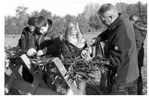
Rudolf Goetzens und Hermann Houbertz vom Wasser- und Bodenverband zeigen, wie Faschinen fachmännisch gebündelt werden.
