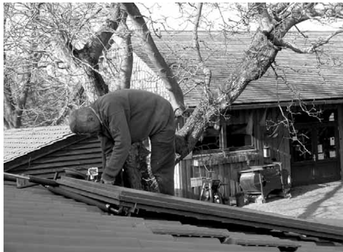
Klaus Kosmol montiert die Solaranlage auf dem Naturschutzhof. Foto: Wiebke Esmann
